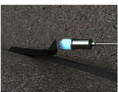
Битумный плинтус сгибают, пламя направляют на нижнюю поверхность плинтуса и одновременно прижимают к углу.
