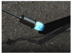
В местах торцевых стыков плинтус разогревается газовой горелкой и укладывается на место с помощью придавливания.
